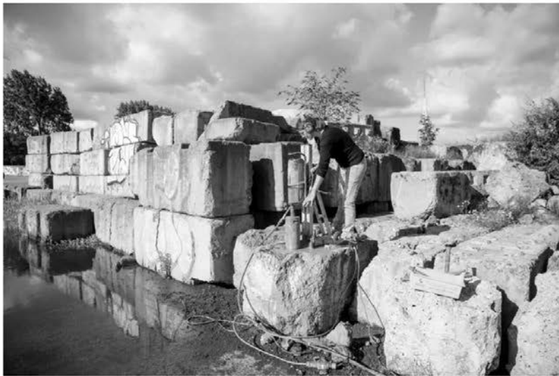
Esther Kokmeijer doet een boring in achtergebleven betonblokken. Beeld Aad Hoogendoorn
